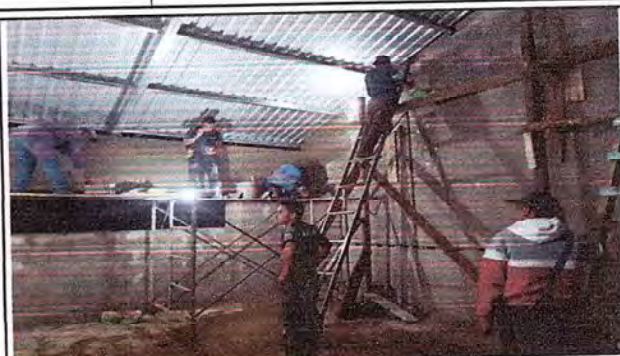
Foto 2: Proceso final de repello de paredes
