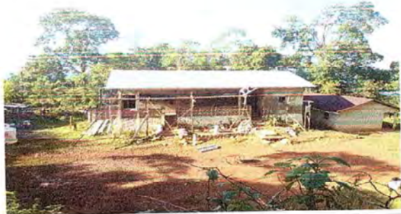
Foto1: Proceso final de instalacion de enlaminado
